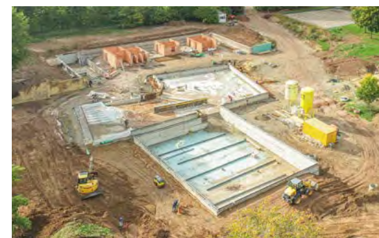
Konstruktion des neuen Beckens
