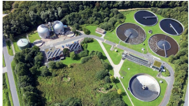
Abb. 1: Die Kläranlage Emden-Larrelt
